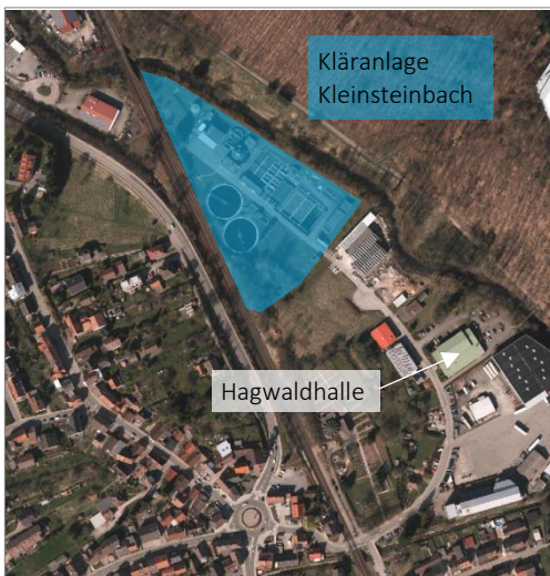
Abbildung 28: Kläranlage Kleinsteinbach und Umgebung
