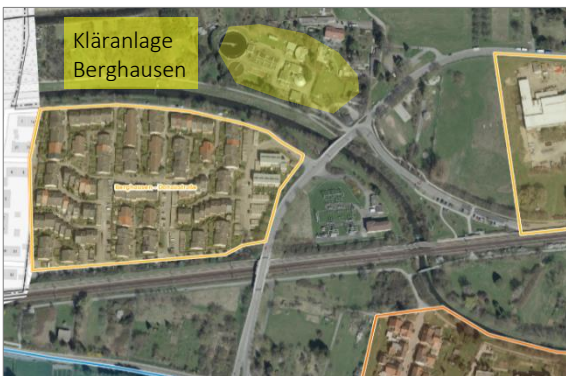
Abbildung 27: Kläranlage Berghausen und Umgebung
