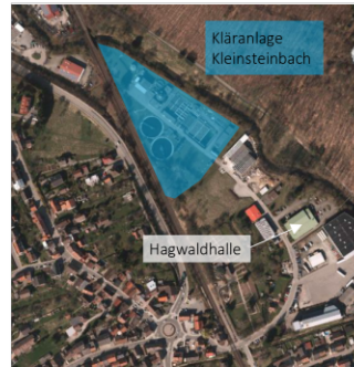
Abbildung 26: Kläranlage Kleinsteinbach und Umgebung
