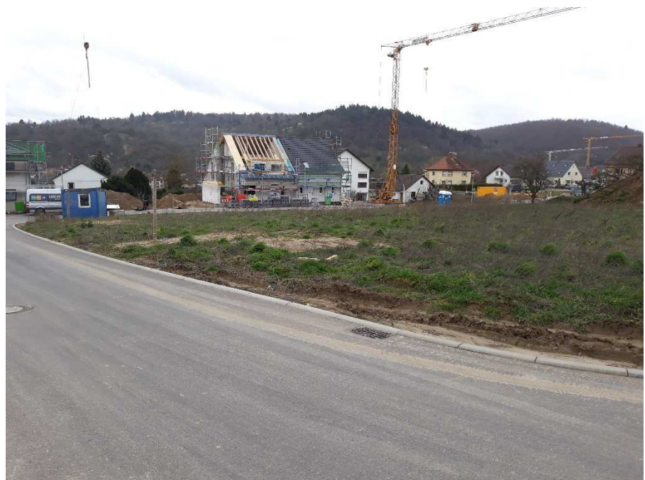
Foto 3: Blick von der Merowingerstraße nach Nordwesten, rechts im Bild das Untersuchungsgebiet.
