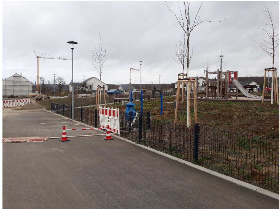
Foto 6: Fast fertiggestellter Spielplatz im Zentrum des Untersuchungsge- biets.
