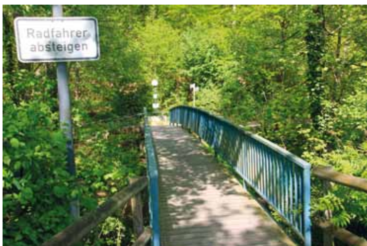
Parkplatz - Brücke über die Pfinz
