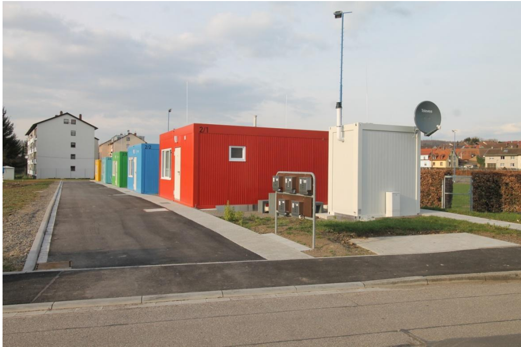
Wärmelieferung für Wohncontainer in Pfinztal.
